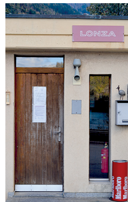
«Steuer-Häuschen» des Pumpsystems, das belastetes Deponie-Grundwasser abfangen soll. © OEKOSKOP
