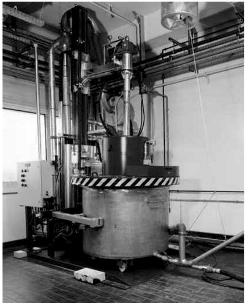
Abb.10: Kesselreinigungsanlage mit Behälter für die Innenbürste. Auf dem Mischbehälter (unten) liegt während der Reinigung der Anlagendeckel, auf dem ein zylinderförmiger Behälter ("Garage") aufsitzt. Durch ihn hindurch führt die Antriebsstange der Innenbürste. Nach Reinigung und Entfernung des Mischbehälters gelangt durch Anheben der Stange die nasse Bürste in die "Garage" zum Abtropfen.
